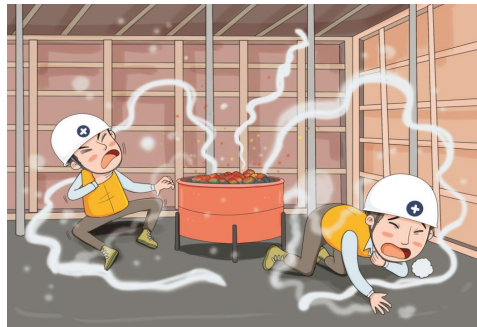
- 콘크리트 양생 고체연료를 교체하기 위해 현장에 들어갔다 일산화탄소 질식 2명 사망
